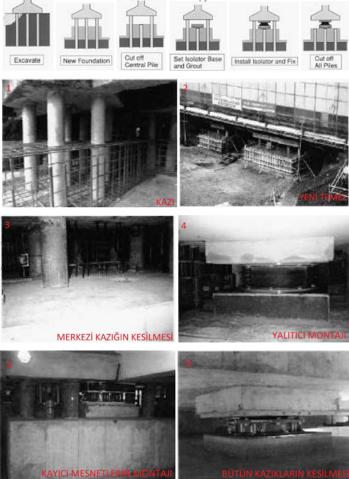
Şekil 53: Japonya'da deprem yalıtımlı güçlendirme uygulaması (Kawamura, 2000)
