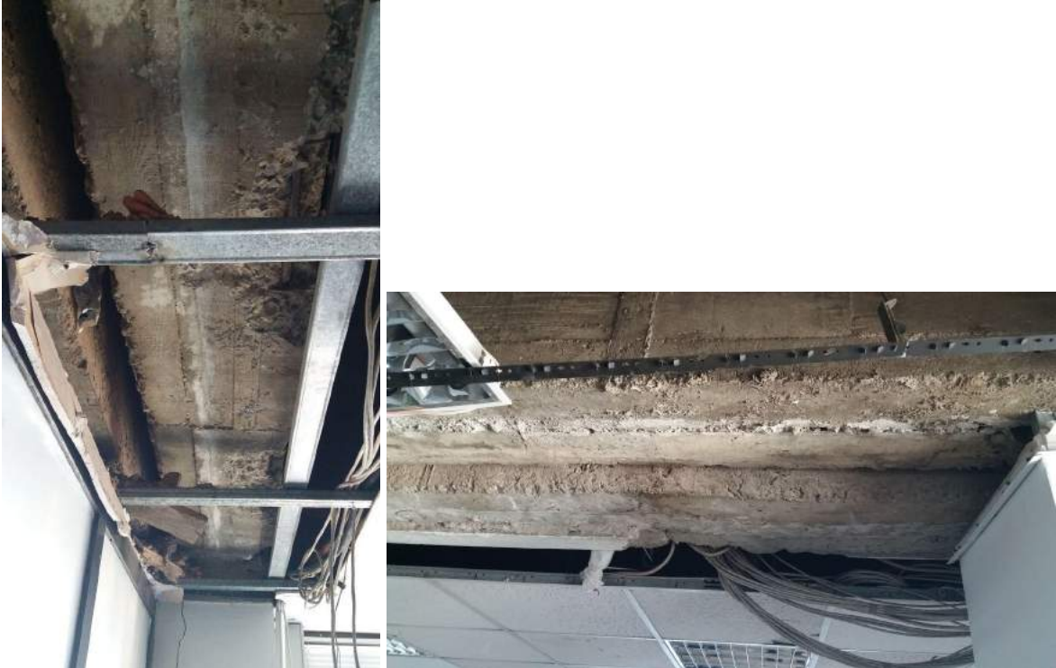
Şekil 30 C Blok ile E blok geçişinde kirişlerin alt kotları arasında oluşan fark ile gözlemlenen görelî oturma
